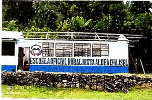
Foto 1: Módulo 1: Inicio del cambio de lámina y colocación de costaneras del aula de la Escuela Oficial Rural Mixta Chajsel.
