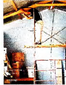
Foto 2: Reparación de sistema eléctrico en el aula.
