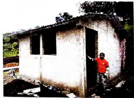
Foto 4: Cambio de techo de la cocina, colocación de costaneras y cambio de puerta y ventanas
