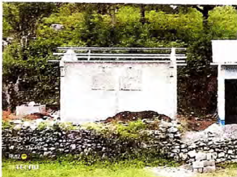
Foto 3: Ejecución del cambio de las vigas de madera a costaneras de la cocina.
