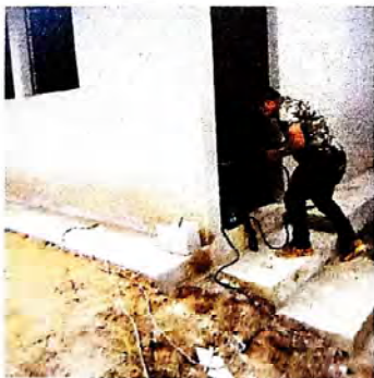
Foto 5: Reparación de sistema eléctrico
